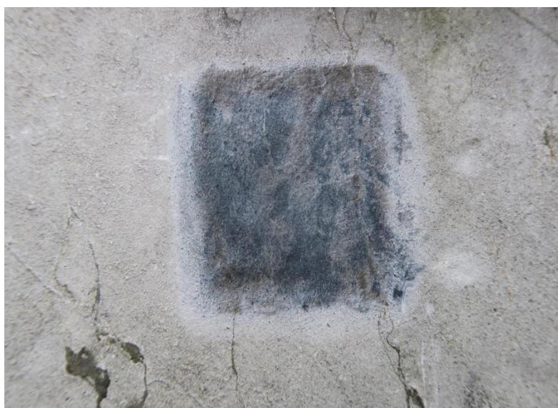
Un essai de ponçage localisé de la surface.
