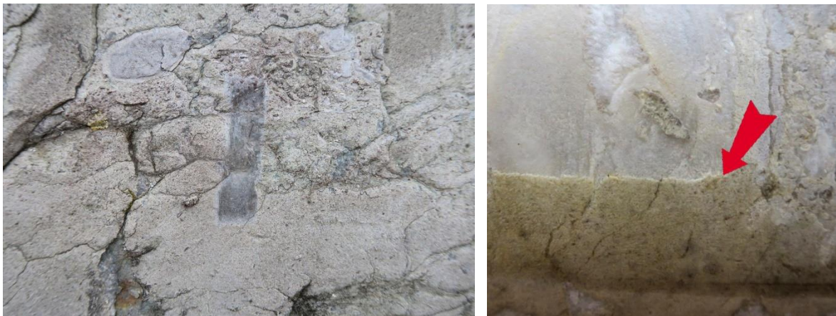
La couche claire (flèche) c'est la pierre sulfatée par les polluants de l'air. Au-dessous la pierre est saine et d'une couleur légèrement plus foncée, selon les zones.
