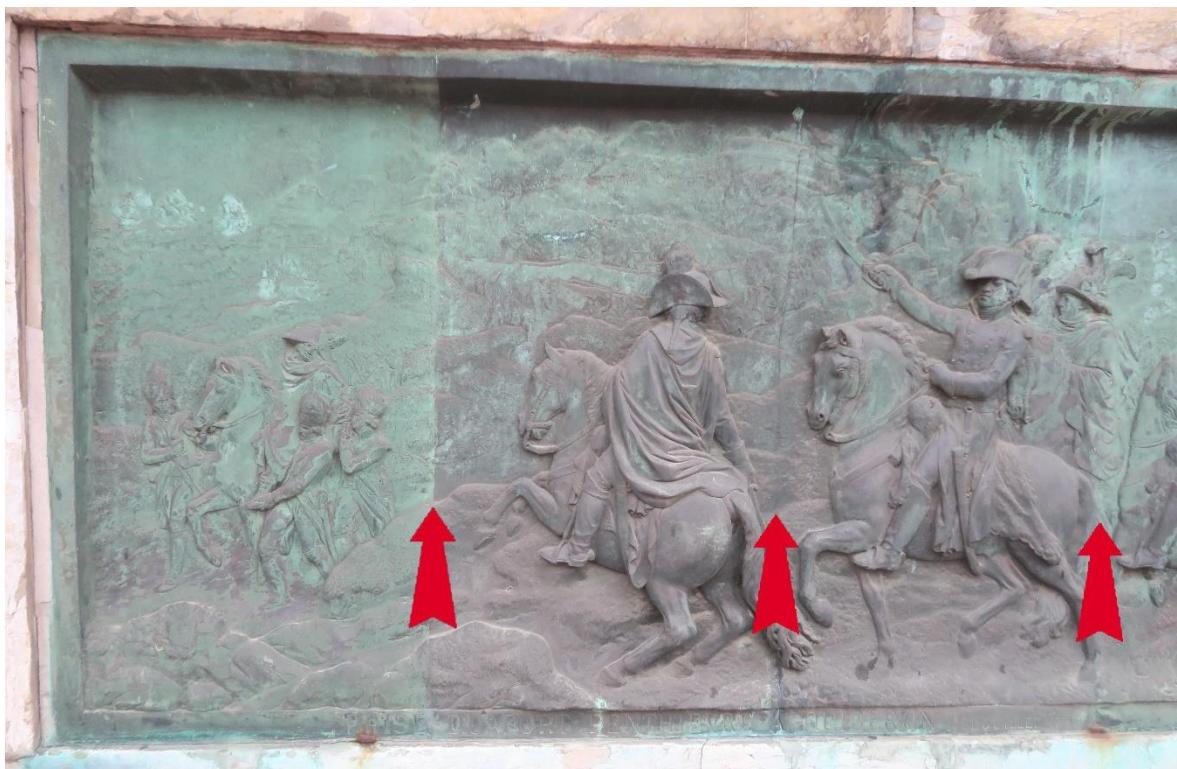
Lignes de séparation (soudures) des panneaux en bronze.
