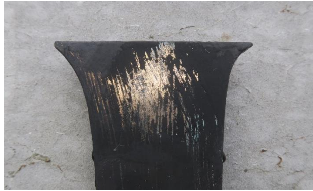
Les lettres en bronze doré, actuellement recouverte d'une teinte noire très tenace.
