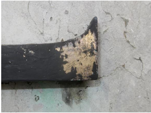
Les lettres en bronze doré, actuellement recouverte d'une teinte noire très tenace.
